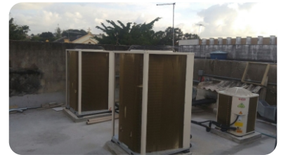
Retrofit de ar condicionado Banco Itaú - Jaboatão/PE
