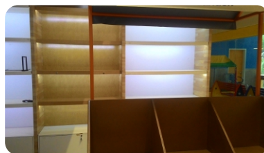
Montagem de estande Flinandek Supermercado Extra - Recife
