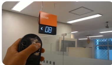
Instalação de painéis Banco Itaú - Recife/PE
