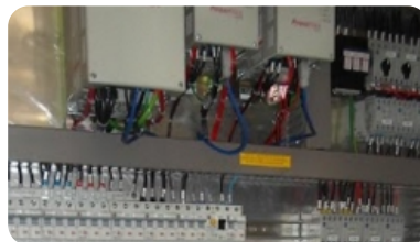
Implantação de esteira transportadora Mondelez - Vitória de Santo Antão
