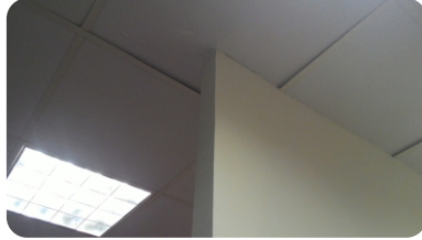
Gesso e Dry-wall Banco Itaú - Natal/RN
