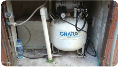
Instalação de compressor Odontologia - Frederico Bandão
