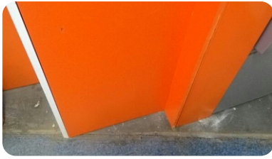
Divisória em madeira (marcenaria) Banco Itaú - São Lourenço da Mata
