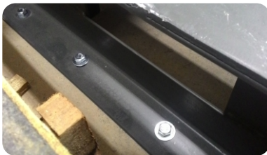
Chumbamento em piso para cofre Banco Itaú - Recife/PE
