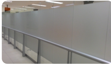
Montagem de biombos em vidro Banco Itaú - Recife/PE
